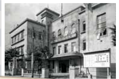
〈昭和33年〉別館増設工事竣工
